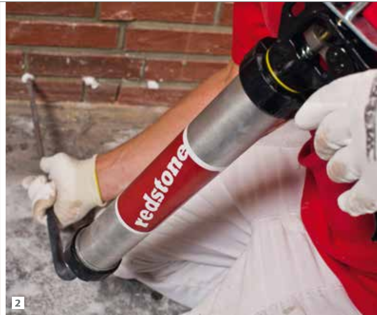
1. Oft dringt Feuchtigkeit langsam und unbemerkt ins Gebäude und schädigt dort langfristig die Bausubstanz. 2. Über die drucklose Handinjektion gelangt die gelartige Flüssigkeit genau in die Bereiche, in denen die horizontale Sperrschicht am besten wirkt. Fotos: redstone GmbH
