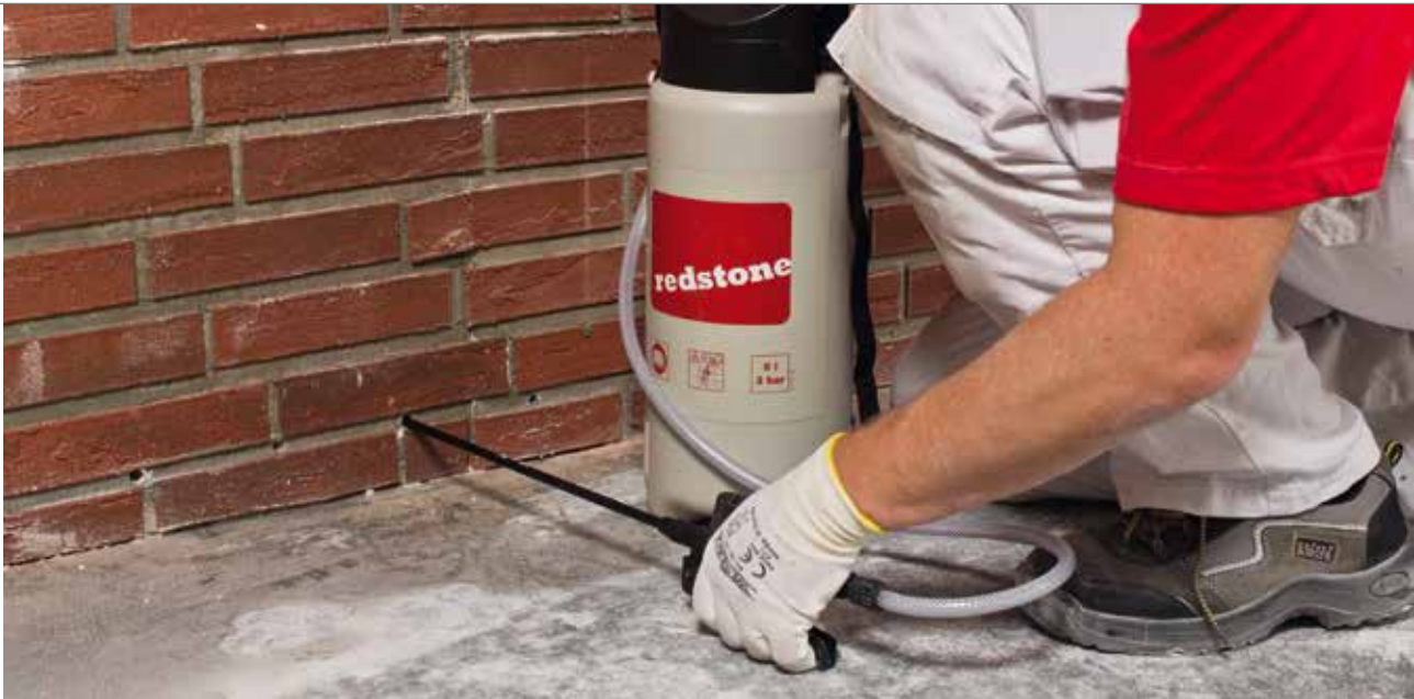
Großgebäude können mit einer speziellen Injektionspumpe schnell und wirtschaftlich verarbeitet werden. Foto: redstone GmbH
