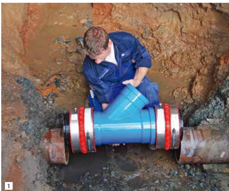
1. Nachträgliches Einbinden eines Abzweigs in bestehende Steinzeugleitung. 2. Die VPC®-Rohrkupplung ist vom DIBt zugelassen. Fotos: Funke Kunststoffe GmbH
