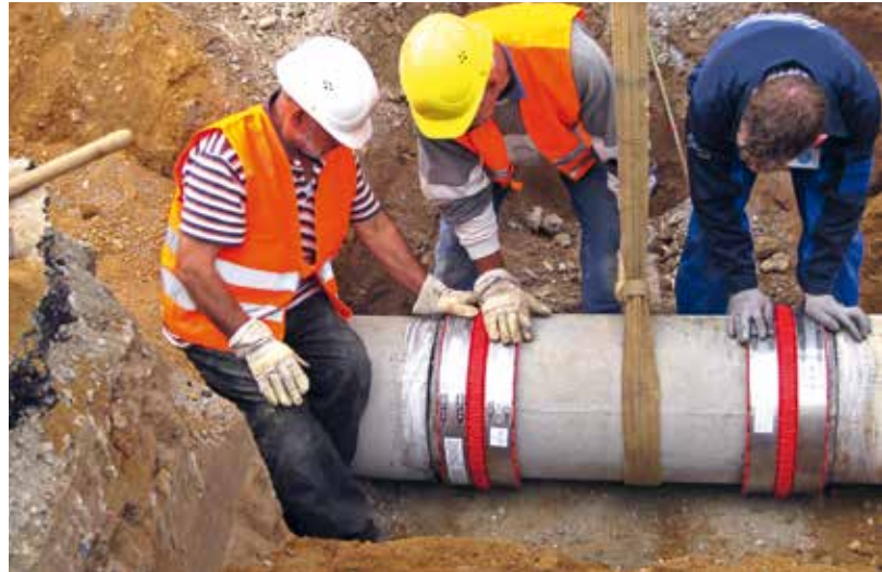
Die VPC®-Rohrkupplung verbindet nennweitengleiche Rohre optimal. Foto: Funke Kunststoffe GmbH
