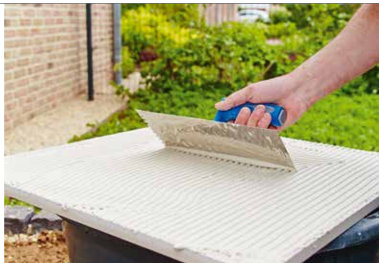
1. Die Haftschrämme tubag TNH-flex ist naturweiß und trassvergütet. 25 Kilo werden mit sechs Liter Wasser so vermischt, dass die Haftschrämme knollenfrei und fließfähig ist. 2. Die Haftschrämme wird mit einer 6-Millimeter-Zahnung vollflächig auf die Unterseite der Platte aufgebracht. Fotos: quick-mix
