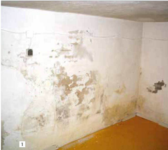
1. Oft dringt Feuchtigkeit langsam und unbemerkt ins Gebäude und schädigt dort langfristig die Bausubstanz. 2. Über die drucklose Handinjektion gelangt die gelartige Flüssigkeit genau in die Bereiche, in denen die horizontale Sperrschicht am besten wirkt. Fotos: redstone GmbH
