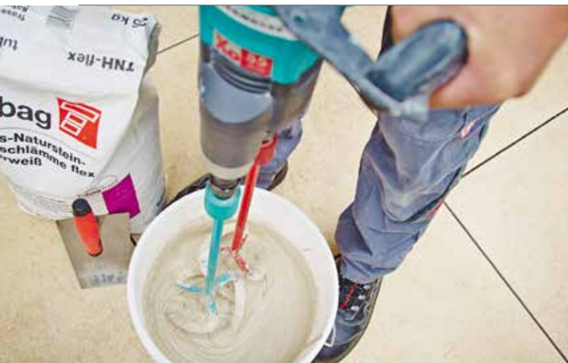
1. Die Haftschrämme tubag TNH-flex ist naturweiß und trassvergütet. 25 Kilo werden mit sechs Liter Wasser so vermischt, dass die Haftschrämme knollenfrei und fließfähig ist. 2. Die Haftschrämme wird mit einer 6-Millimeter-Zahnung vollflächig auf die Unterseite der Platte aufgebracht. Fotos: quick-mix
