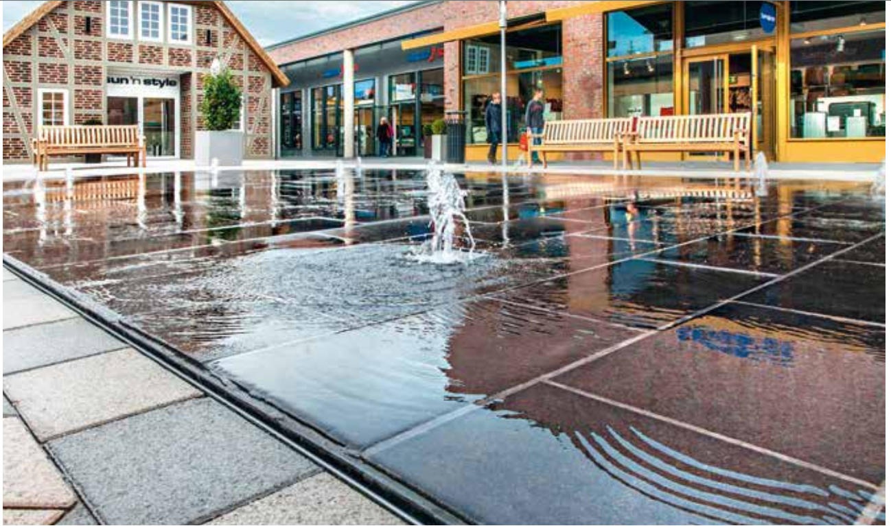
Schlitzaufsatzrinnen im Outletcenter Soltau. Foto: ANRIN GmbH
