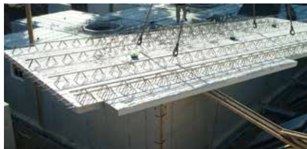
Verlegen der fdu-Elementdecke.
