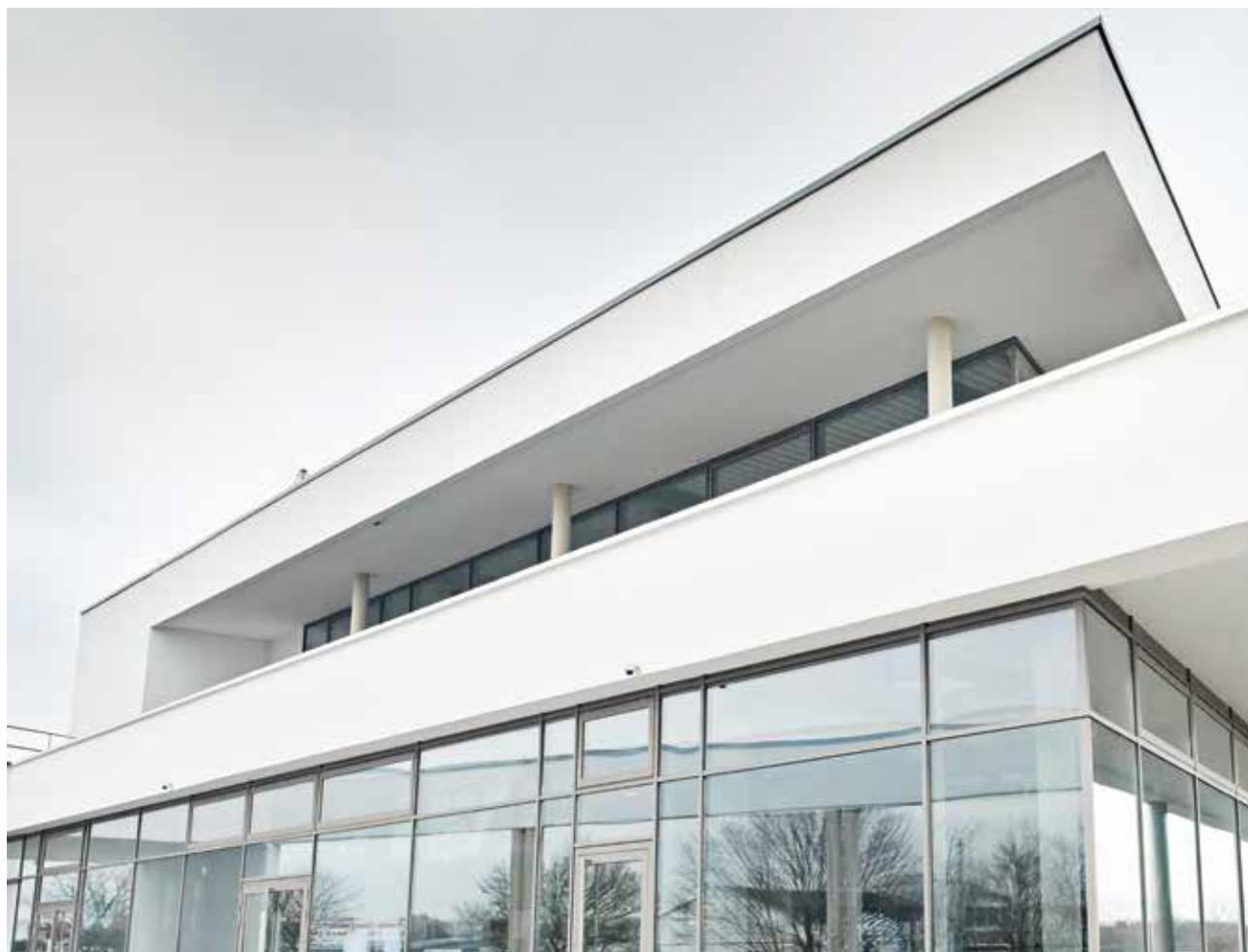
Häufig sind Außendecken wichtige Gestaltungsmerkmale von Gebäuden und immer öfter entstehen auch sie in Trockenbauweise. Rigips-Außendeckensysteme können in geschützten sowie in bewitterten Außenbereichen eingesetzt werden. Je nach Anwendungsbereich und bauspezifischen Gegebenheiten empfehlen sich geprüfte Systeme auf Basis der gipsgebundenen, vliesarmierten „Rigips Glasroc X“-Platten oder der zementgebundenen „Rigips Aquaroc“. Foto: Saint-Gobain Rigips GmbH, Düsseldorf
