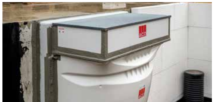
Druckwasserdichter Anschluss von ACO Therm® Block, Lichtschacht und Aufstockelement.
