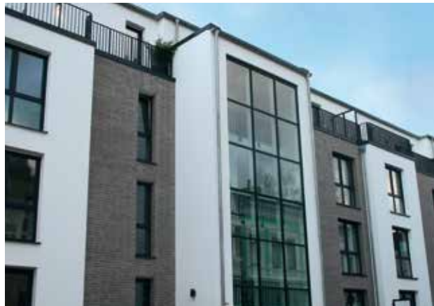
Vorgehängte Fassade mit Riemchen. Foto: Wienerberger
