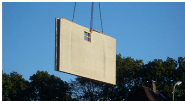
Lieferung einer fdu-Elementwand
