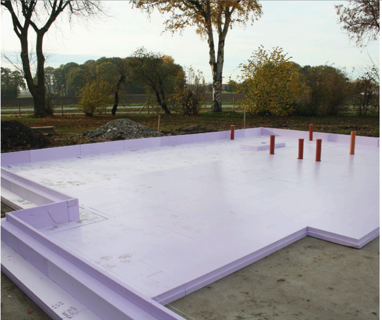
Energieeffizientes Bauen fängt mit der Bodenplatte an. Das kombinierte Wärmedämm- und Schalungssystem JACKODUR® Atlas macht eine konventionelle Holzschalung überflüssig. Dies spart viel Zeit bei der Ausführung. Foto: JACKON Insulation
