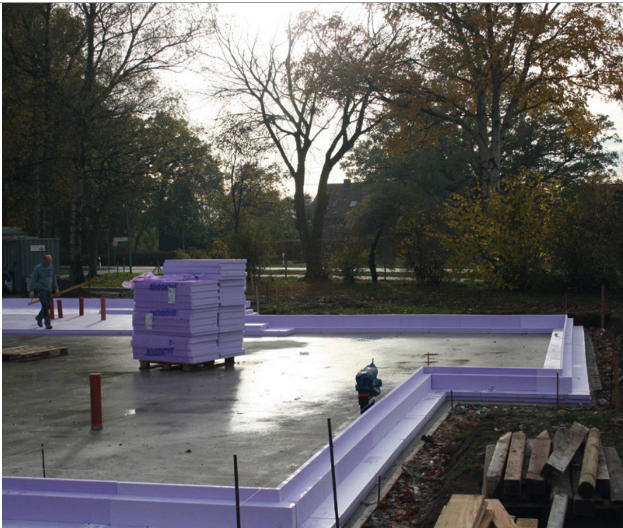
Die Flächenelemente lassen sich dank des einfachen Stecksystems mühelos und zügig verlegen. Foto: JACKON Insulation
