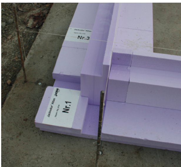
Hier passt alles zusammen. Die Randelemente werden passgenau produziert und nummeriert an die Baustelle geliefert. Eine einfache und wärmebrückenfreie Verarbeitung ist damit sichergestellt. Foto: JACKON Insulation
