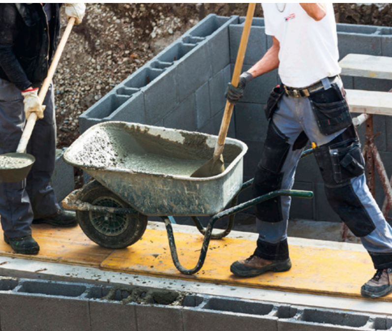
Wände aus KLB-Schalungssteinen überzeugen mit hoher Tragfähigkeit und hervorragendem Schallschutz. Sowohl Beton-Förderung als auch Verarbeitung und Nachbehandlung der Schalungssteine sollten dabei stets von Fachleuten ausgeführt werden, die in die Handhabung des KLB-Schalungssystems eingewiesen wurden. Foto: KLB Klimaleichtblock
