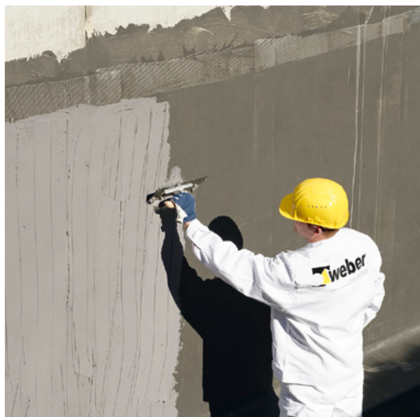
Die Bauwerksabdichtung mit weber.tec Superflex D 24 schützt nicht nur vor Feuchtigkeit, sondern auch vor Radongas. Foto: Saint-Gobain Weber
