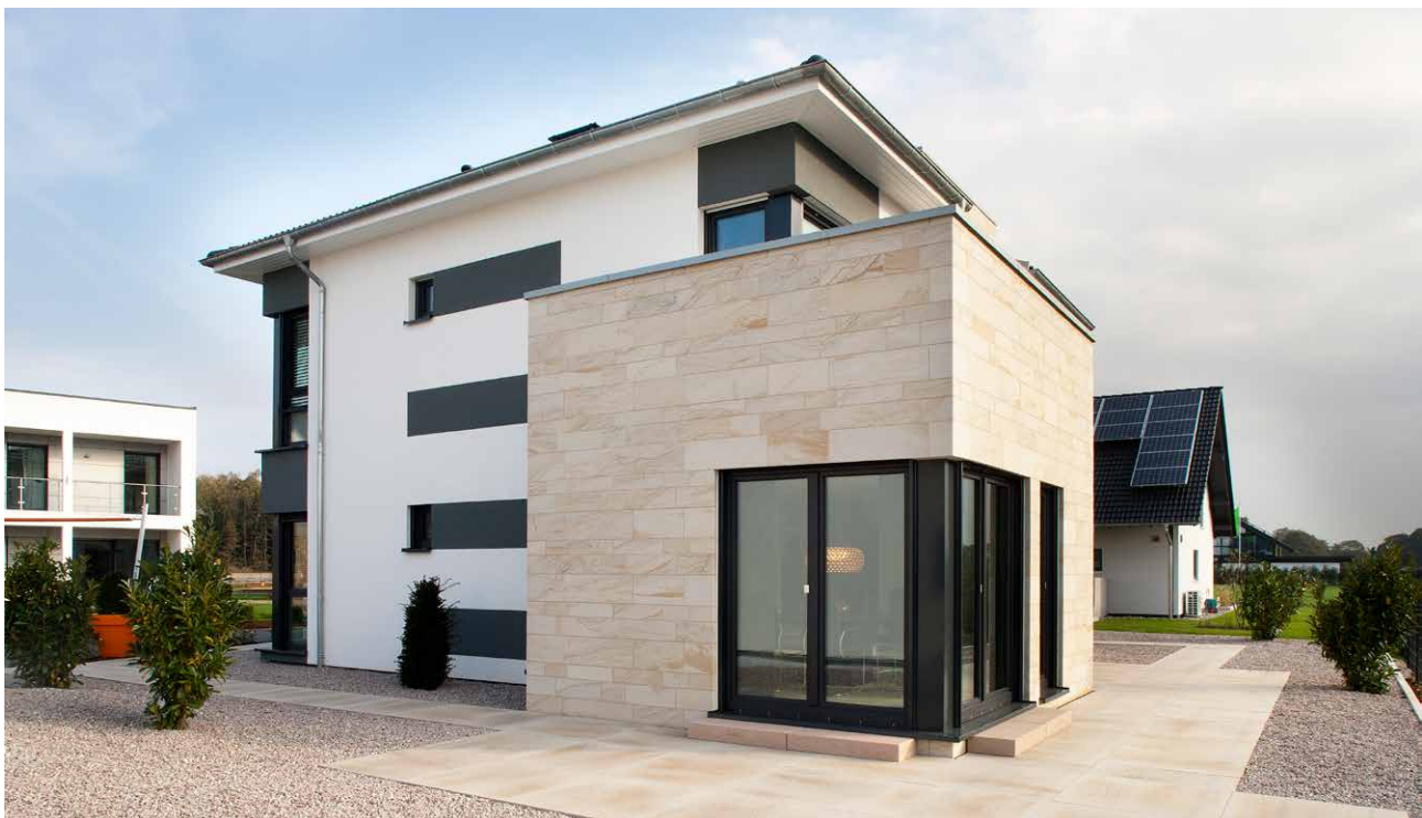
Wärmedämm-Verbundsystem mit Sandstein. Foto: Knauf
