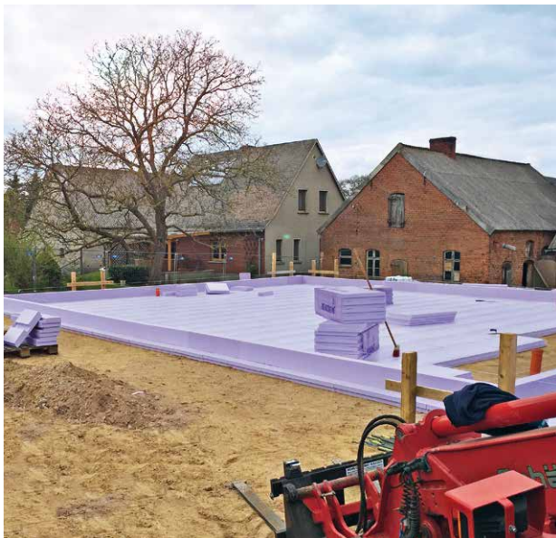
Die Bodenplattendämmung JACKODUR Atlas aus solidem XPS-Material verhindert Wärmeverluste und sorgt für stets warme Füße im Neubau. Foto: JACKON Insulation GmbH
