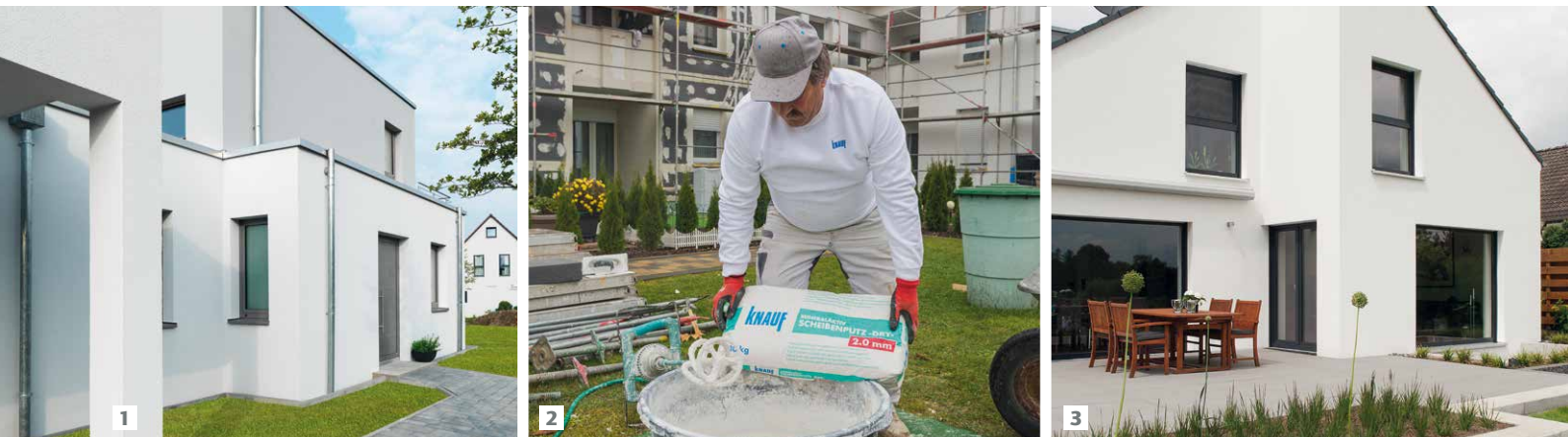
1. Dank kontrolliertem Feuchtemanagement bietet das biozidfreie Fassadensystem Knauf MineralAktiv effektiven Schutz gegen Algen und Pilze an der Fassade. Foto: Knauf/Stefan Ernst 2. + 3. Der pulverförmige MineralAktiv Scheibenputz Dry wird mit Wasser angemischt. Fotos: Knauf/Mathias Lehmann
