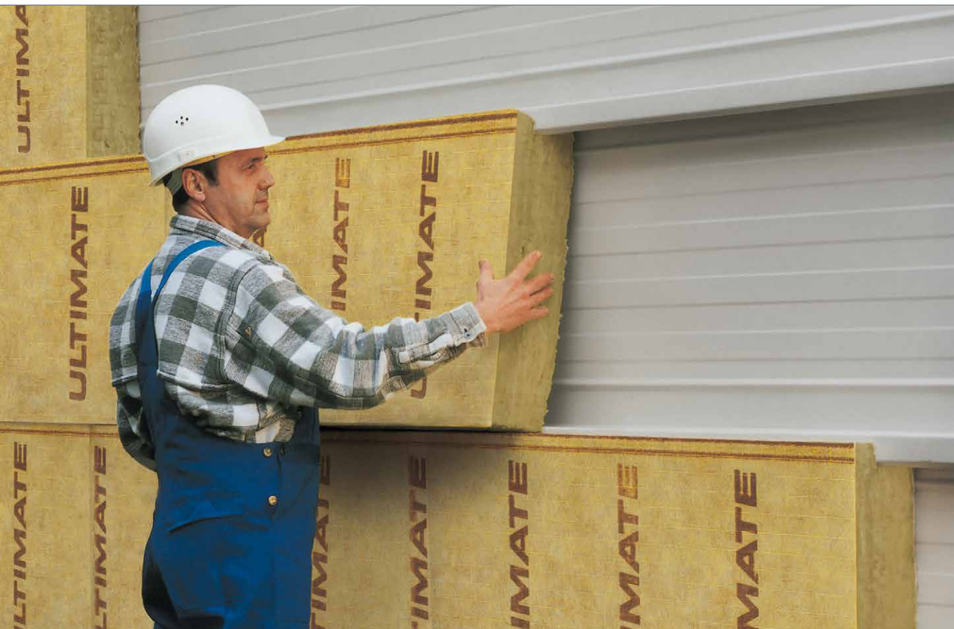
Planern, Architekten und Verarbeitern steht mit ISOVER Metac WS-PLUS inklusive des neuen Wandkassetten-Befestigers Metac WSB-PLUS-RLR ein System zur Verfügung, das einen besonders raschen Arbeitsfortschritt ermöglicht und zudem mit Blick auf gesetzliche Vorgaben Planungssicherheit gibt. Foto: SAINT-GOBAIN ISOVER G+H
