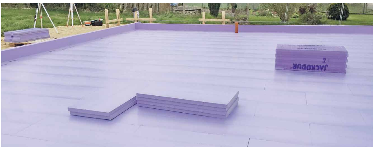
Die JACKODUR Atlas Bodenplattendämmung verhindert zuverlässig Wärme- und somit Energieverluste. Foto: JACKON Insulation GmbH
