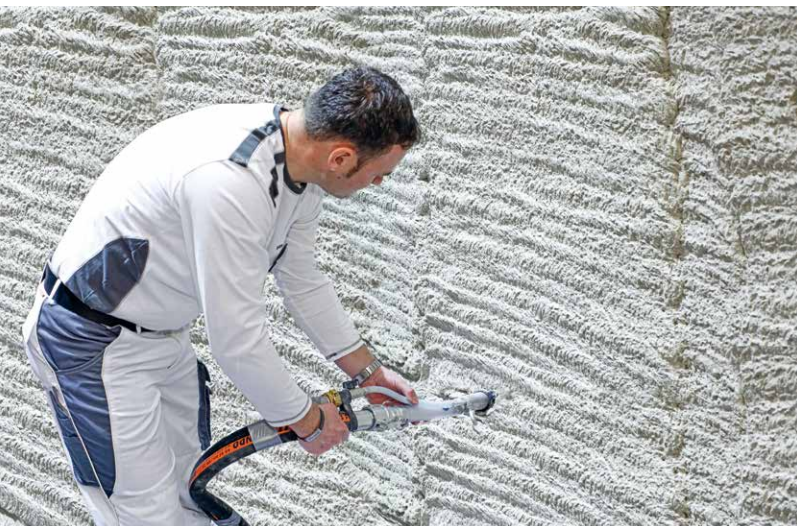
TRI-O-THERM M besticht auf der Baustelle durch seine leichter Verarbeitbar- und hohe Ergiebigkeit. Foto: Schwenk Putztechnik
