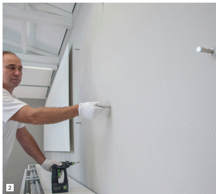
1. Die Wandabsorber werden mit einem einfachen Klick an den Wandmagneten befestigt und lassen sich jederzeit nachjustieren oder auch wieder abnehmen, etwa wenn der Raum dahinter gereinigt werden soll. 2. Einschrauben der Magnete für die Befestigung eines Wandabsorbers. Fotos: Knauf/Bernd Ducke
