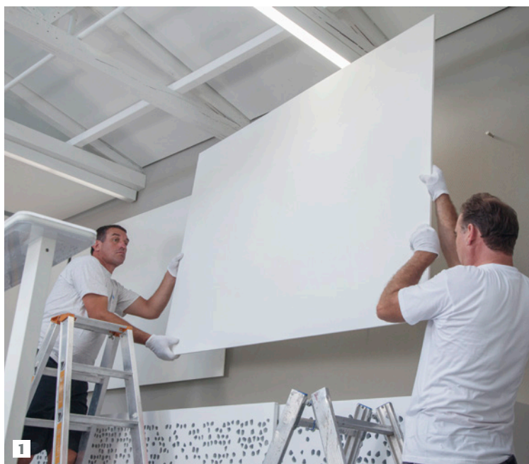
1. Die Wandabsorber werden mit einem einfachen Klick an den Wandmagneten befestigt und lassen sich jederzeit nachjustieren oder auch wieder abnehmen, etwa wenn der Raum dahinter gereinigt werden soll. 2. Einschrauben der Magnete für die Befestigung eines Wandabsorbers. Fotos: Knauf/Bernd Ducke
