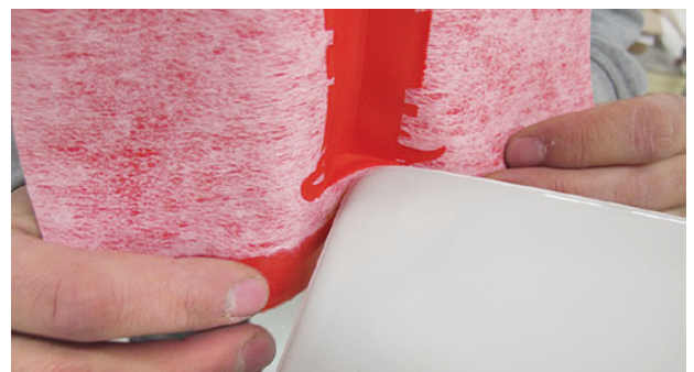
Die elastische Zone der Sopro WannenDichtEcke schmiegt sich an alle Wannenradien an. Foto: Sopro Bauchemie GmbH
