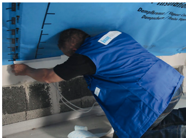
Das LDS Einputzband muss faltenfrei an der Dampfbremse befestigt werden. Foto: Knauf Insulation
