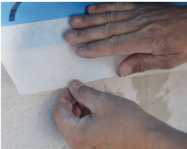
Durch das Zurückschieben der Dampfbremse wird eine Entlastungsschleife ausgebildet. Foto: Knauf Insulation
