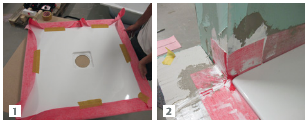
1. Fixierung der Bänder an der Wanne mittels Kreppband für die Wannenmontage. 2. Auch die kompliziertesten Anschlüsse lassen sich sicher lösen. Fotos: Sopro Bauchemie GmbH
