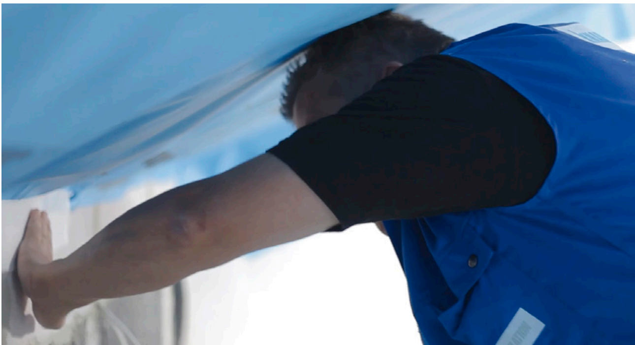
Beim Befestigen an der Wand ist Faltenwurf zu vermeiden. Foto: Knauf Insulation
