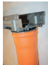
Anschließen des KG-Rohres DN 100
