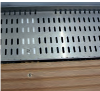
Verschraubung des Rinnenkörpers durch die 4-mm-Dränschlitzte im Rinnenboden
