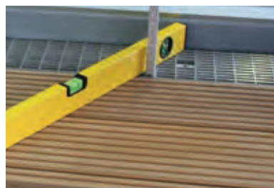
Einpassen der Holzterrassenrinne
