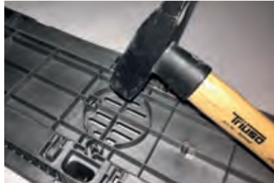
Ausschlagen der Bereich für den Einsteckstutzen
