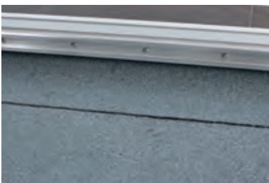
Anschluss einer bituminösen Abdichtung mit Keilausbildung
