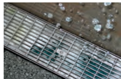
Wasserpegel bis Unterkante Abdeckrost
