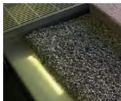
Einbringen von Splitt und anschließendes Verlegen des Plattenbelages
