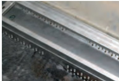
Prüfungsaufbau mit Dränagematte und Splittbett vor dem Rinnenkörper
