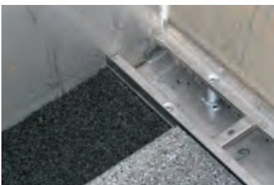
Rinnensystem lose verlegt
