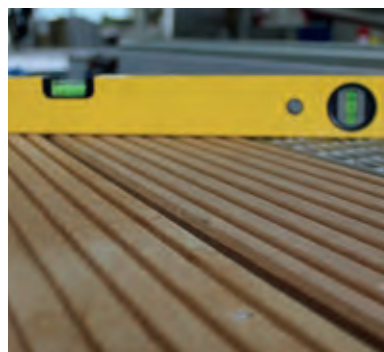
Kontrolle der Einbauhöhe
