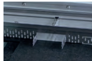
Ansetzen der Rinnen mit der Auskrugung zum Anschlussbereich
