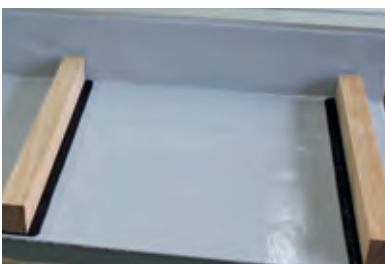
Verlegen der Lagehölzer auf der Abdichtung. Empfohlener Abstand für den Rinnenkörper sind 50 cm.
