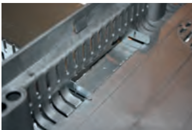
Einschieben des Stichkanals
