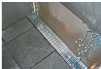
Beregnung der Fassadenrinne im Einbau
