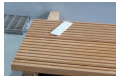
Rinnenkörper nach Notwendigkeit baureits unterfüttern
