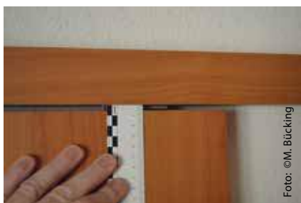
Abbildung: Nicht fachgerecht montierte Schiebetüren. Die Tür weist links oben ein Spaltmaß von 11 mm auf, rechts oben lediglich von 5 mm.
