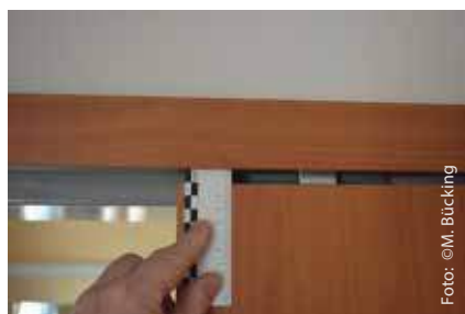
Abbildung: Nicht fachgerecht montierte Schiebetüren. Die Tür weist links oben ein Spaltmaß von 11 mm auf, rechts oben lediglich von 5 mm.
