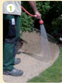
1 Schottertragschicht anfeuchten
