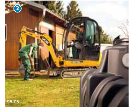
Die Baugrube wird ausgehoben.
