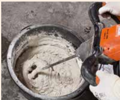
▲ 1. Anrühren Pura Wärmedämmputz anrühren
