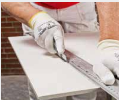
▲ 1. Zuschneiden Vivo Masterclima ausmessen und zuschneiden
