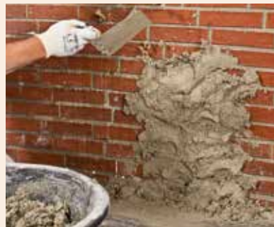
▲ 2. Auftragen Pura Wärmedämmputz auftragen
