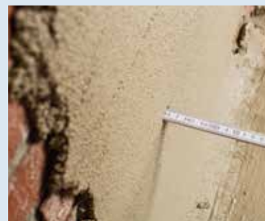
5. Messen Kontrolle der Schichtdicke (mindestens 1,5 cm!)
