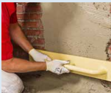
4. Glätten Secco Sperrputz glätten oder filzen
