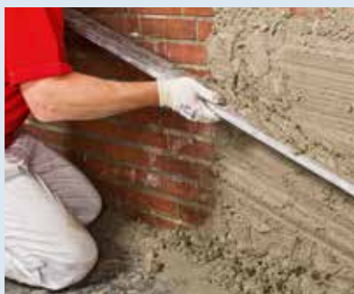
3. Abziehen Secco Sperrputz abziehen
