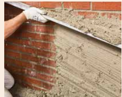
▲ 3. Abziehen Pura Wärmedämmputz abziehen und glätten
