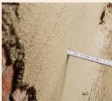
4. Messen Kontrolle der Schichtdicke (20–30 mm)
