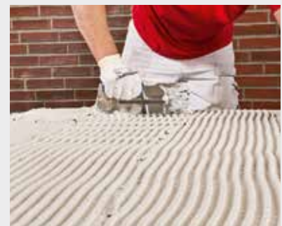
▲ 3. Auftragen Kleber auf die Plattenrückseite auftragen
