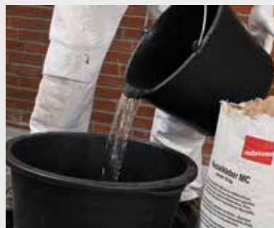
▲ 2. Anrühren Kleber mit Wasser anrühren
