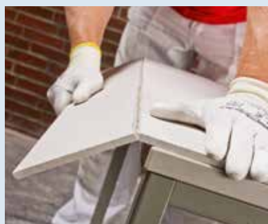
▲ 2. Zuschneiden Secco Universal Sanierplatte (USP) ritzen, brechen und fassen
