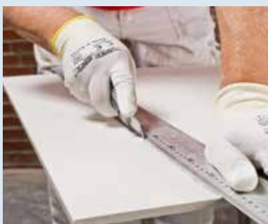
▲ 1. Ausmessen Secco Universal Sanierplatte (USP) ausmessen
