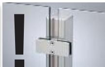
Die Scheiben werden von außen (Nachbarseite) mit den Klemmbacken an die Pfosten befestigt
