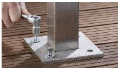
Pfosten ausrichten und montieren.
