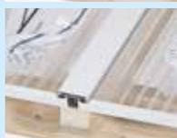
Bei Bedarf kann der TEJEALU-Profilabschlusswinkel (Bremswinkel) mit einer Zange auf die gewünschte Länge abgekniffen werden. Nun wird der TEJEALU-Profilabschlusswinkel (Bremswinkel) an der unteren Profilstirnseite vor Kopf verschraubt. Bei Verwendung des TEJEALU-Klemmdeckels wird der TEJEALU-Profilabschlusswinkel auf dem Klemmdeckel geschraubt.
